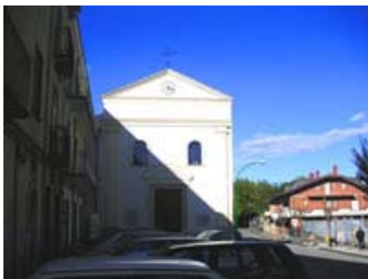
Foto 1 - Campanile Chiesa S.Silvestro
