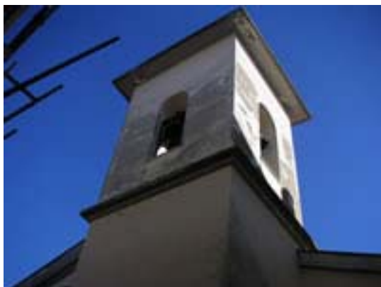
Foto 2 - Campanile Chiesa S.Silvestro
